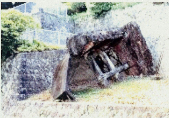
▲ 爆風で飛ばされた旧天主堂の鐘楼ドーム
