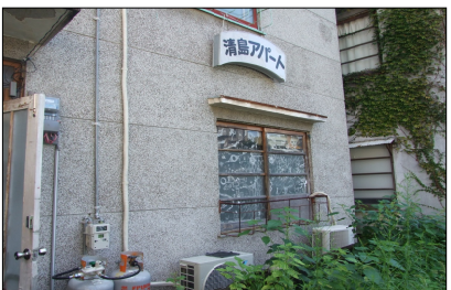
→清島アパート入口側
